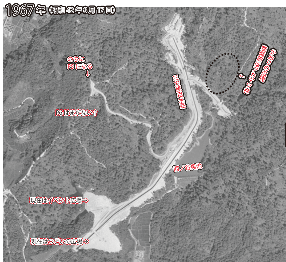
「MCB672XC9-4 1967（昭 42）」（国土地理院）を彩色、加筆加工して作成 のちに西ノ谷奥池・スポーツ広場となる谷部の西縁に沿う形で三方原用水路が造られた。P5 から西ノ谷奥池方面 に伸びる道は幅広く整備されている。のちのイベント広場とつどいの広場はこの工事期間に切り拓かれている。
