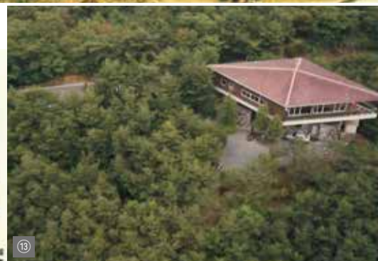
森林公園会館 1985 年（昭和 60）頃 鉄骨二階建。2 階テラスは展望台となっていた。 ただ、この写真のように、開所から 20 年後には アカマツが育ち眺望は失われてしまったようだ。
